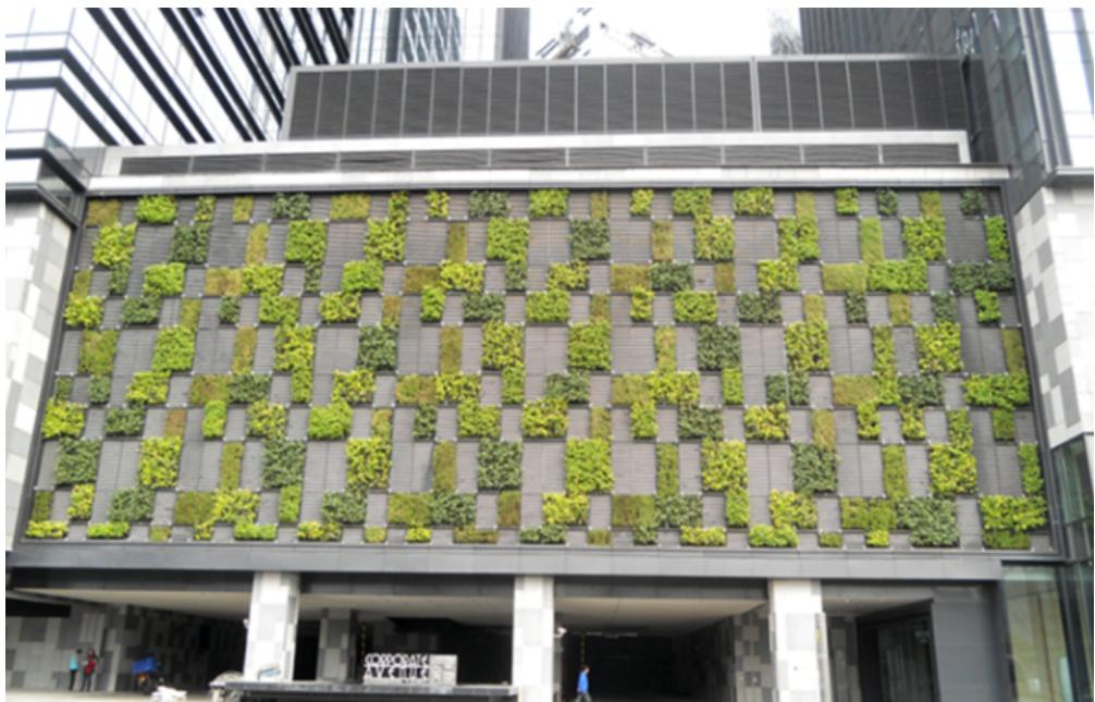
立体绿化的灌溉技术的选择：由于建造室内立体绿化一般都有保持较高的景观要求，所以大部分立体绿化都要求较高的密度，所以立体绿化是不适合喷淋系统的，绝大多数的水源是无法进入植物根系部位的，所以一般立体绿化都采用了内置的滴管系统，及在立体绿化承载结构的上方防止一排或多排水源滴头，只要将水源滴入上方的植物就行了，水源或收到垂直重力的影响循序渐进的往下面滴，来逐一湿润培植植物的基质，通过疏松的基质达到保湿和过滤渗漏的作用，以保持植物必要的水源及养份条件，让植物得以存活，当然这一整套浇灌设施是通过一个能够定时开启和闭塞的控制阀门来控制的，已到达无需人工浇灌的目的，也成为半智能的浇灌系统。广西小区立体绿化公司立体绿化中的屋顶绿化是指屋顶绿化包括在各种城市建筑物、构筑物等的顶部以及天台、露台上的绿化。
